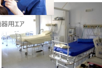
病院用空気供給装置
