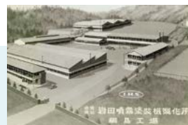
1950年代に新設された綱島工場
